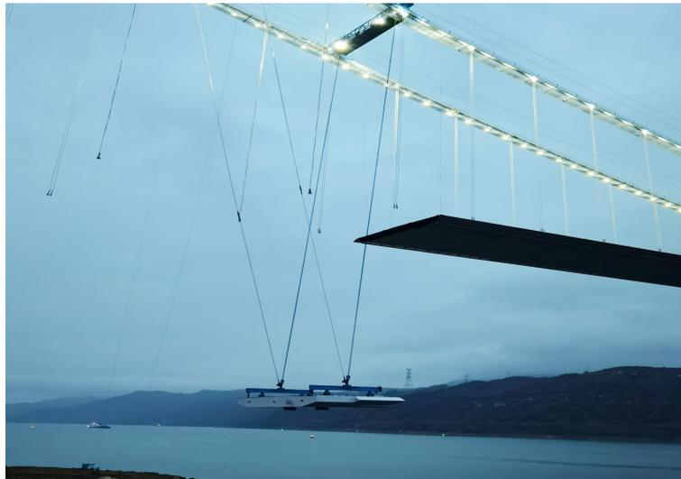
图 6 加长吊索与转向耳板连接
