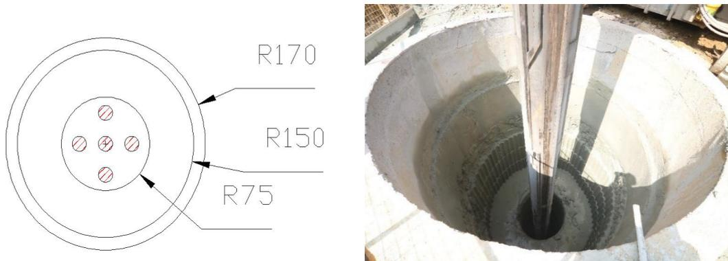
2.为了获得较好的爆破效果，应结合工程地质情况、钻孔深度及技术经济成本选用直径为 120mm 的钻头在桩基 2.8m 范围环形布孔，布孔间距根据弹性理论公式并结合现场实际情况进行计算，最终确定桩基炮眼间距为 30cm。
