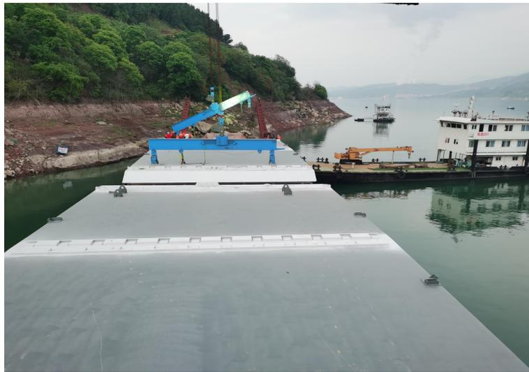
图4 跨缆吊机连接钢箱梁临时吊点连接
