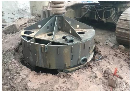
4.实施精细化钻进控制：采用“低速缓进-动态调垂-分层取样”工艺，通过刻度盘水准仪双控保障垂直度 $\leq 1\%$ ，每2m在地层变化处取样核验；运用化学泥浆护壁减渣技术，结合终孔前钻头往复修孔，确保孔径、孔深、沉渣厚度等指标100%符合设计规范。
