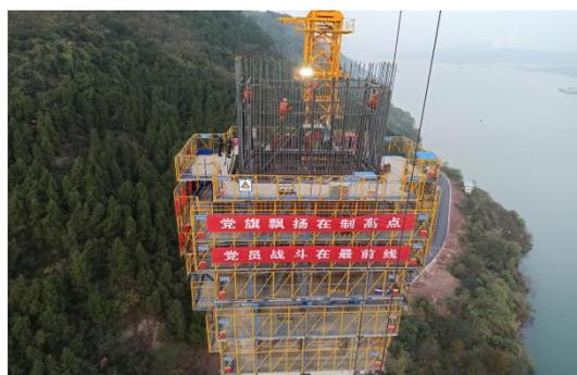
(2) 液压爬模系统爬升工艺：本工程液压爬模系统采用标准化流水施工工艺：混凝土浇筑后依次进行拆模后移→安装附墙装置→提升导轨（换向盒同步向上调整）→整体爬升架体（换向盒同步向下调整，专人监控同步性）→钢筋绑扎→模板处理（清理并涂刷脱模剂）。关键控制点在于：1）预埋件采用爬锥+高强螺杆组合固定（螺纹孔黄油密封），确保埋件与模板精准定位；2）实行“一榀一专人”的同步爬升管控体系，通过液压阀门实时调节不同步架体；3）实施周转
