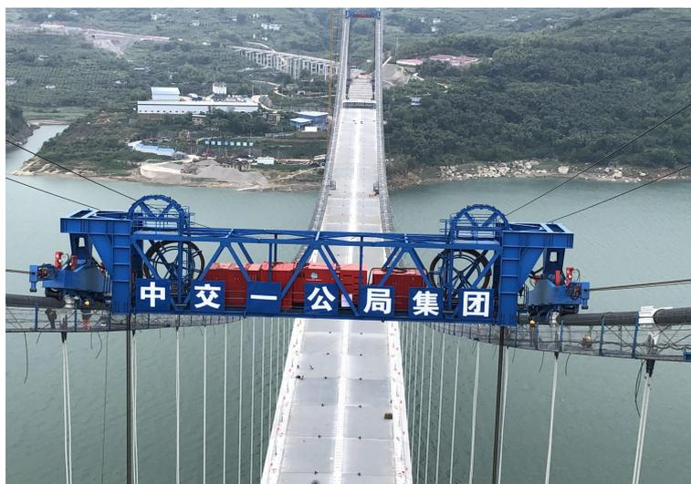
图 2 跨缆吊机定位
