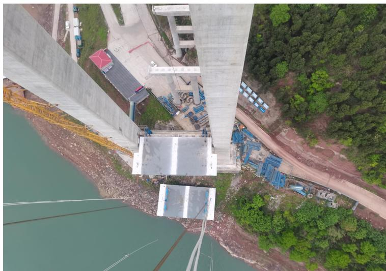
图10 端梁前吊后支
