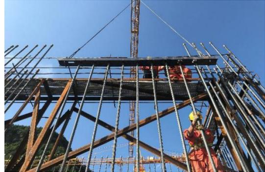
(2) 本项目劲性骨架采用  $Z75 \times 5\text{mm}$  和  $L50 \times 3\text{mm}$  角钢组成空间桁架结构，在加工厂分段预制后分 4 大标准块运输至现场。安装时通过塔吊分节段吊装，采用临时固定+测量校正+间断焊接（30cm 间距）的施工工艺，重点控制骨架定位精度（垂球校核）和焊接质量（外观检查无咬边、裂纹等缺陷），确保与塔柱结构精准匹配。该标准化预制、模块化安装的施工方法既保证了结构精度，又提高了施工效率。
