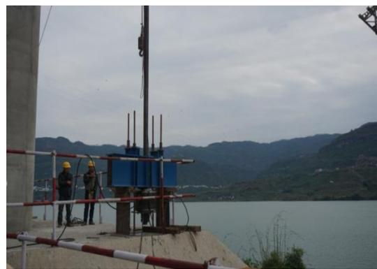
(4) 根据两岸不同的地形条件和施工特点，系统配置了 4 台 15t 提升卷扬机、 $\phi 32\text{mm}$  提升钢丝绳（南岸可采用  $\phi 26$  钢丝绳 12 线方案）、索塔门架、80t 移位器纵移平车、10t 手拉葫芦（牵拉与反拉各 2 个）、80t 滑车组等专业设备。其中北岸创新采用 32a 槽钢滑轨配合 10t 电动葫芦反拉系统，
