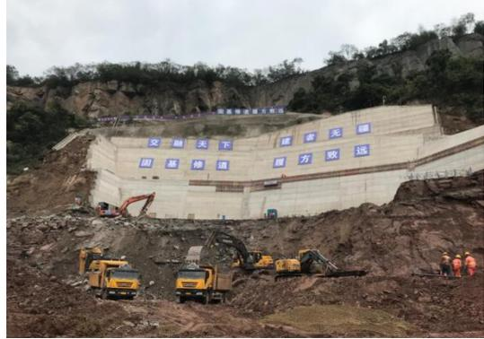
2.为分析爆破施工工艺可行性，建立了基坑区周边岩体的三维实体有限元模型，开展典型爆破工况的数值模拟。研判了爆破振动导致的危岩体和边坡支护结构的爆破振动速度，支撑爆破开挖方案的可行性并提出了合理的控制措施。现场爆破振动监测印证了理论分析的正确性。爆破施工期的危岩体和边坡振速始终未超过控制值。
