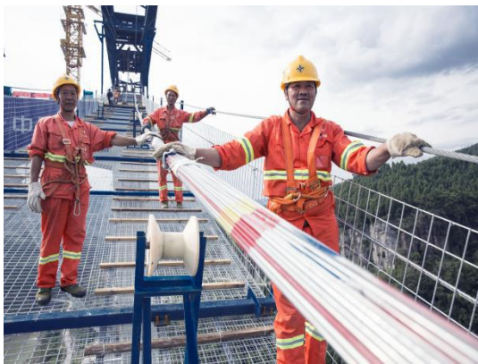
基准索股架设标记法施工技术
