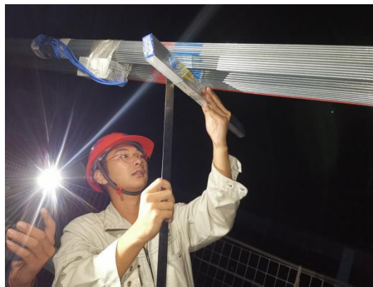
基准索股架设标记法施工技术
