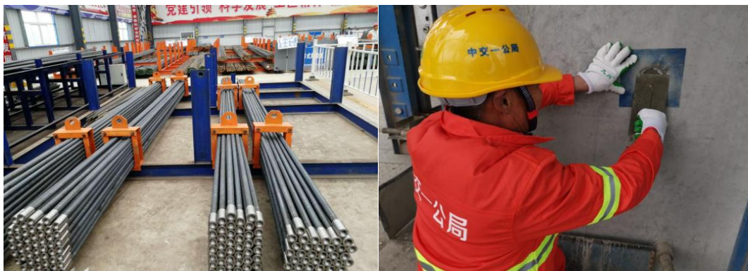
半成品钢筋制作及拉杆孔修补
