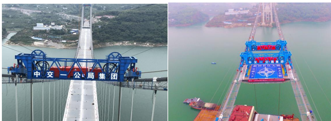
钢箱梁智能化吊装设备
