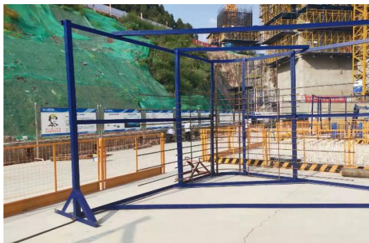
圆弧倒角钢筋定尺架体
