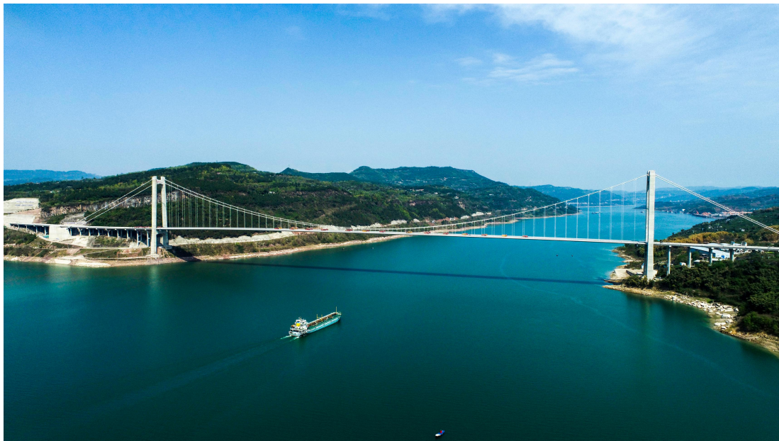
新田长江大桥（成桥）
