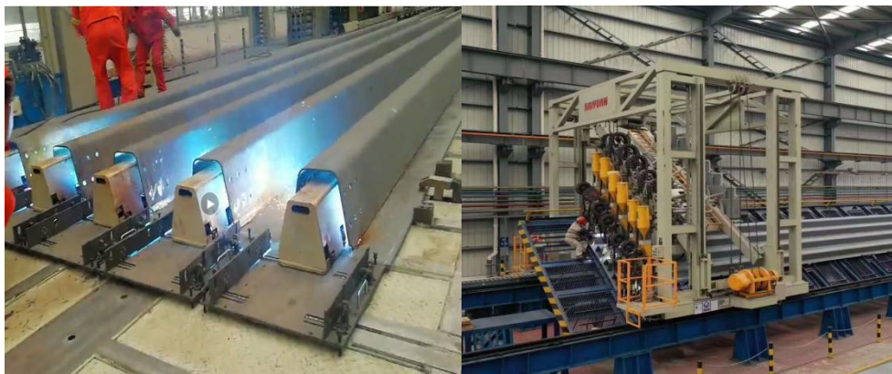
钢箱梁钢桥面板 U 肋内焊工艺
