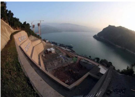
锚碇基坑施工
