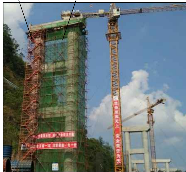
满堂脚手架作业平台示例一
