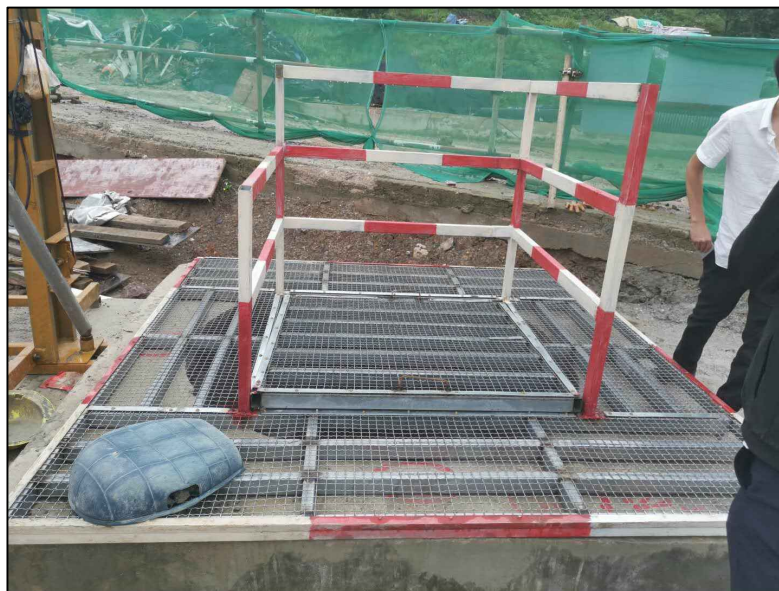
孔口、洞口防护示例
