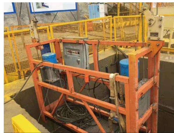
人工挖孔桩人员上下专用吊篮示例
