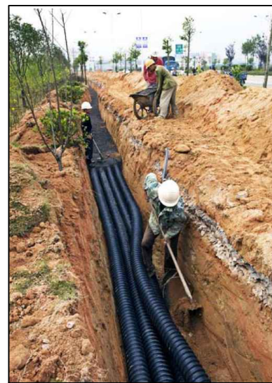
线缆埋地示例
