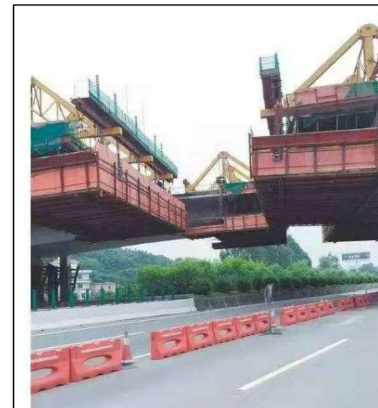
挂篮作业平台示例（二）
