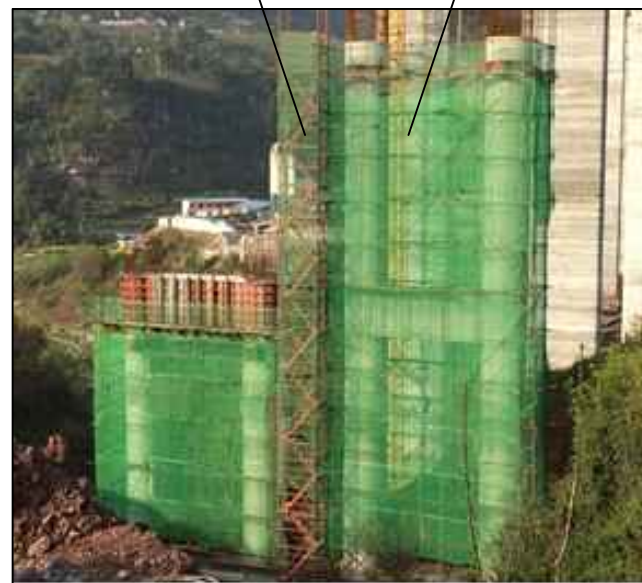
满堂脚手架作业平台示例二
