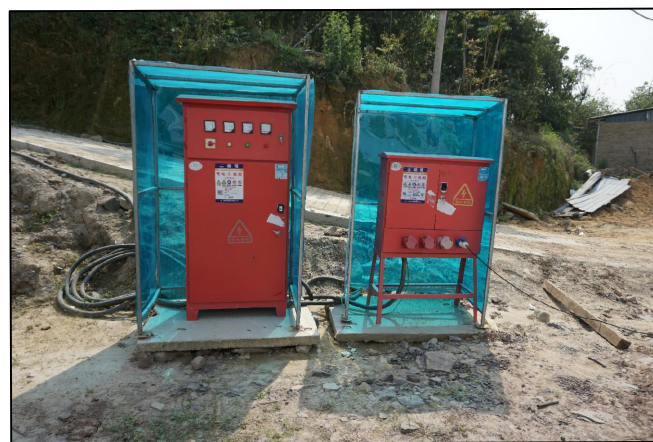
配电箱防护棚（固定）示例
